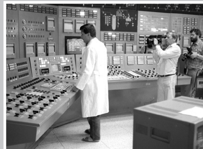
Zahájení zkušebního provozu 4. bloku 19. července 1987
