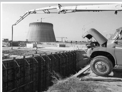
Výstavba chladičích věží a betonáž základové desky
