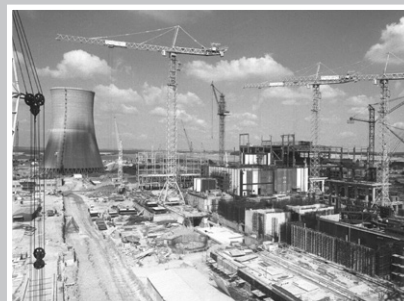
Staveniště HVB 1 v létě 1983
