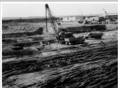
Začátky vlastní výstavby
